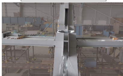
「マスマス整流ます」設置
