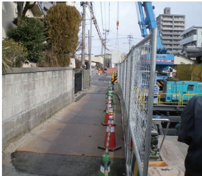
余裕の施工幅
