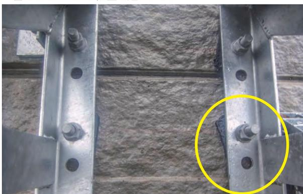
▼既設擁壁との間に隙間が生じる場合は、不陸調整材で調整します。
