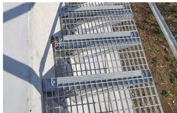
▼滑り止めプレートを設け、滑りにくさをよりアップさせています。
