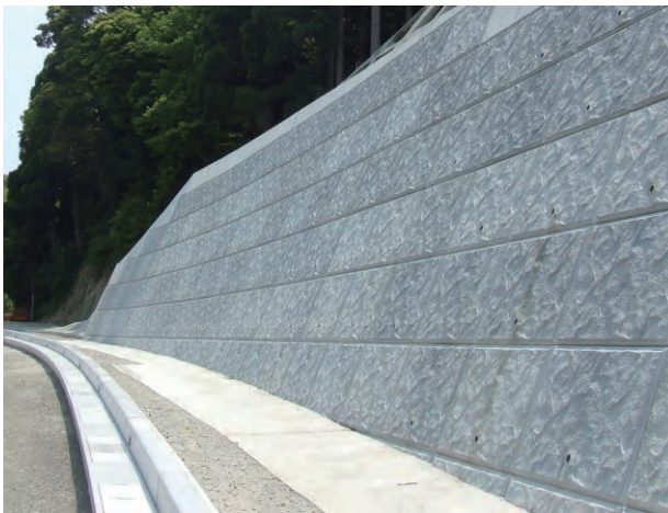
擬岩タイプ (階段積みもたれ式擁壁)
