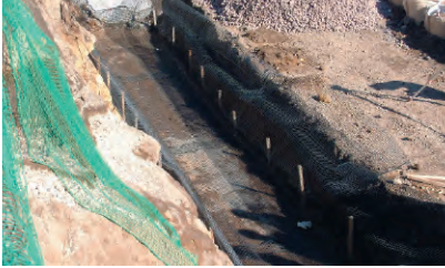
1.かごテンサー基礎敷設
