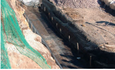
1.かごテンサー基礎敷設
