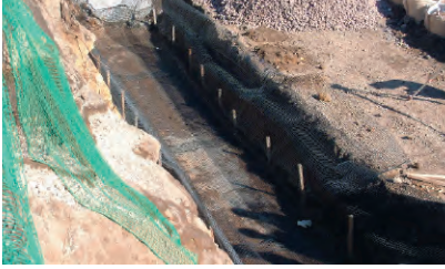
1.かごテンサー基礎敷設
