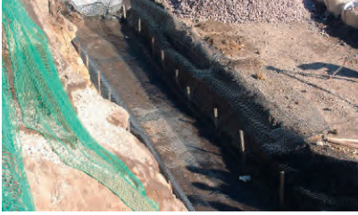
1.かごテンサー基礎敷設
