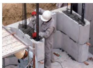
⑤ 縦貫コンクリート打設
