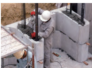
⑤ 縦貫コンクリート打設
