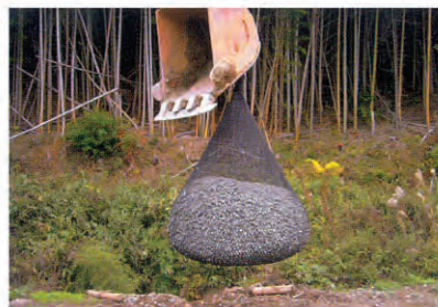
⑤吊上げ移動
