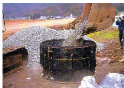
②中詰め材投入
