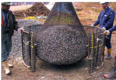
④型枠開放
