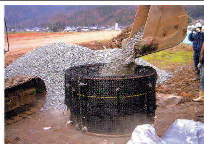
②中詰め材投入
