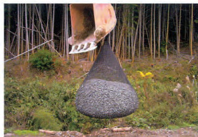
⑤吊上げ移動
