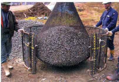
④型枠開放
