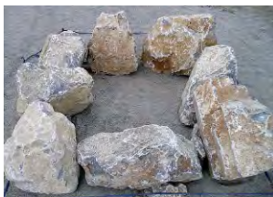
外周石8個設置状況。
