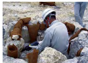
石材に削孔します。
