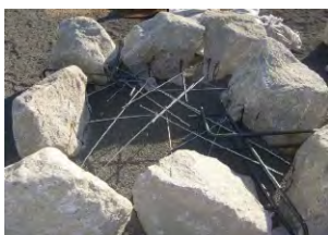
連結筋が必要な場合アンカー部材と同時にセッティングします。
