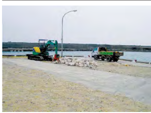
敷き砂で製作ヤードを整地します。
