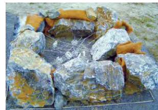
削孔した部分に、接着剤で専用アンカー部材を取付けます。
