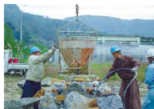
所定の容量の生コンクリートを投入し、打設します。
