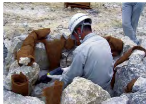
石材に削孔します。
