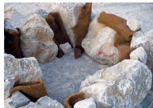
石材間に、間詰用割栗石とシートを用いて養生を実施します。
