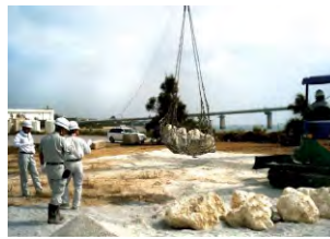
石材品質と凹凸を見ながら、所定の石材を選別します。
