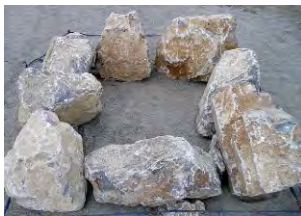
外周石8個設置状況。
