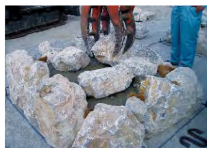
天端石を植石し養生。その後、間詰材を撤去します。
