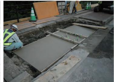
⑥所定高さまで打設。埋戻し・養生。
