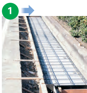
KCフォームの上に配筋した状態
