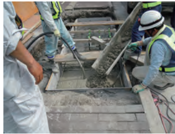
⑤生コン打設。周辺埋戻し。
