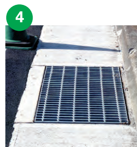
グレーチング設置
