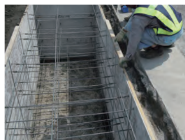
③型枠レベル調整
