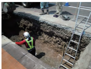
①掘削後敷砂
