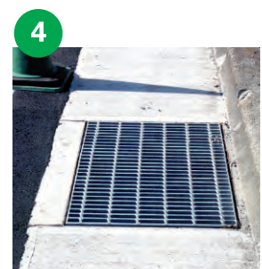
グレーチング設置
