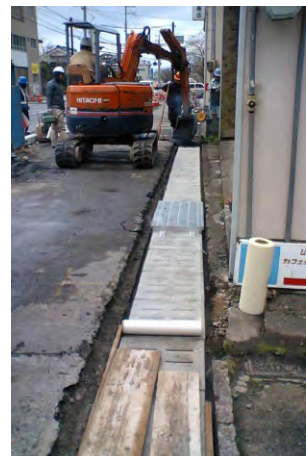
▼繊維ネット敷設
