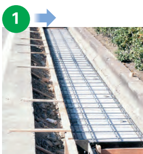
KCフォームの上に配筋した状態
