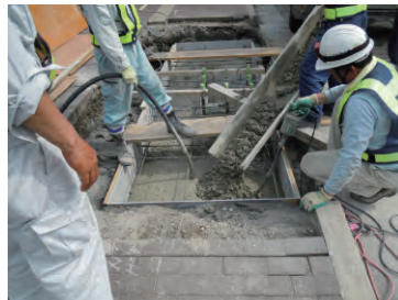
⑤生コン打設。周辺埋戻し。
