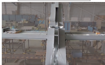
「マスマス整流ます」設置
