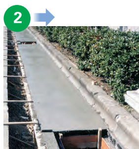
コンクリート打設
