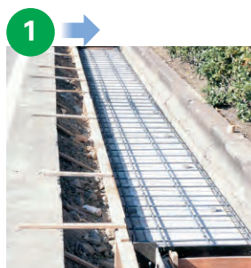
KCフォームの上に配筋した状態
