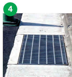
グレーチング設置
