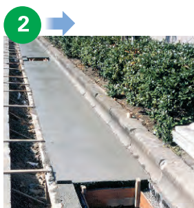
コンクリート打設
