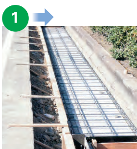
KCフォームの上に配筋した状態
