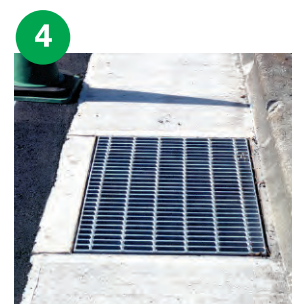
グレーチング設置
