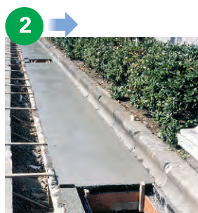
コンクリート打設
