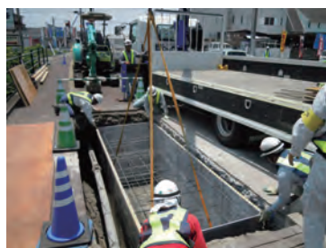
②KCスタンドフォーム据付け
