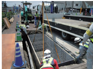
②KCスタンドフォーム据付け
