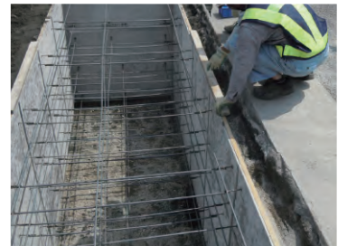
③型枠レベル調整
