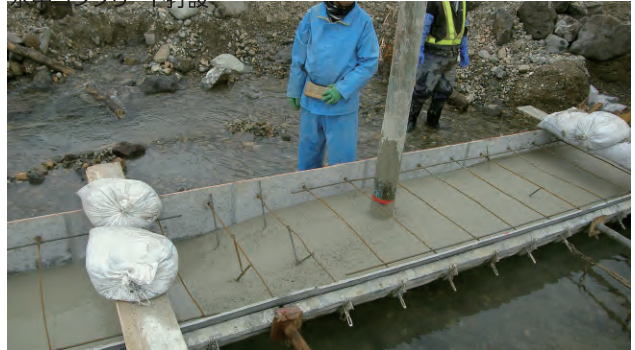
水中コンクリート打設
