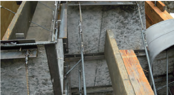
型組状況 支保材はアングル(既製品)を使用。 背面のサポート筋と溶接して固定。
