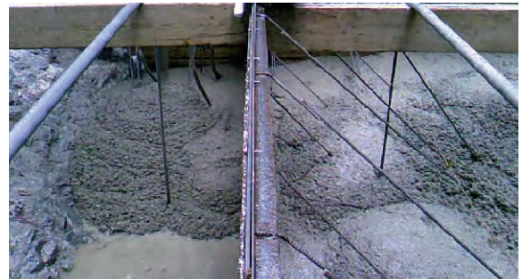
生コンは交互に打設。 生コン圧を打ち消しあい、補強を最低限に抑えます。
