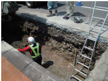
①掘削後敷砂
