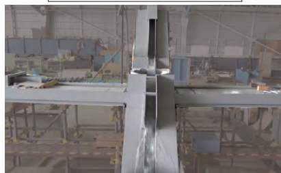
「マスマス整流ます」設置
