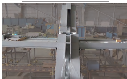
「マスマス整流ます」設置
