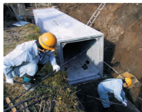
7. PC鋼より線を4穴に通す
