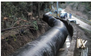
▲上水道管(誘導管)
