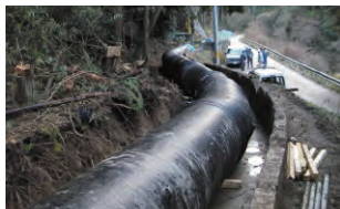
▲上水道管(誘導管)
