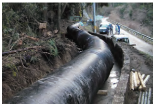
▲上水道管 (誘導管)
