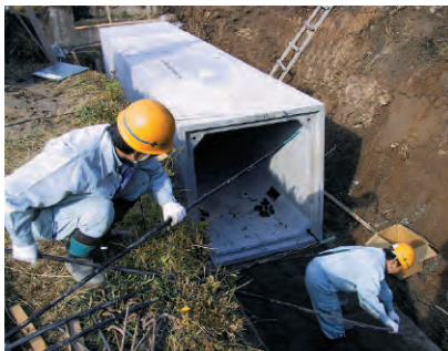
7. PC鋼より線を4穴に通す
