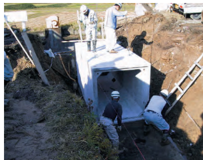
5. 普通型を据付
