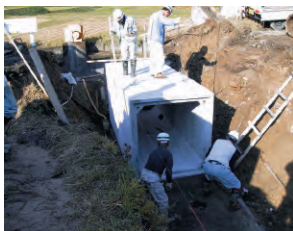
5. 普通型を据付
