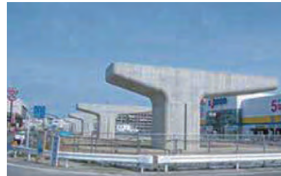
▼高架下部工事
