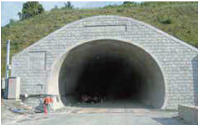
▼トンネル工事
