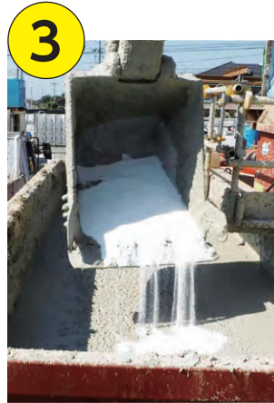
●バックホウで15分程度混合 (ドライミキシング等を使用すると、より均一に混合することができます)
