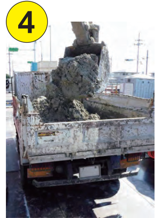
●MT処理土をダンプトラックに積込み、搬出
