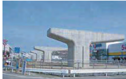
▼高架下部工事
