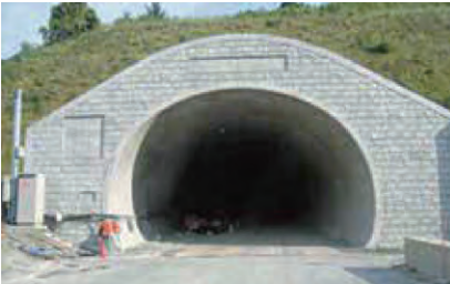
▼トンネル工事
