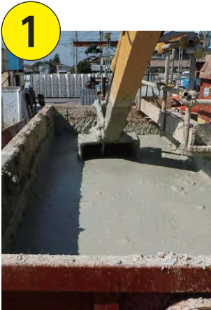
●泥をピットに投入
