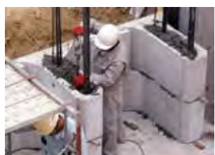
⑤ 縦貫コンクリート打設
