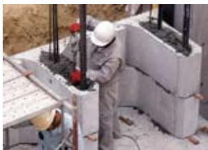
⑤ 縦貫コンクリート打設
