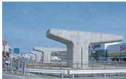
▼高架下部工事
