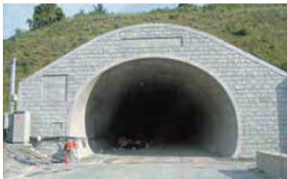
▼トンネル工事
