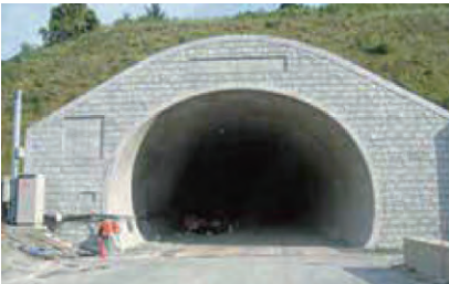
▼トンネル工事
