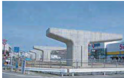
▼高架下部工事
