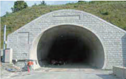
▼トンネル工事
