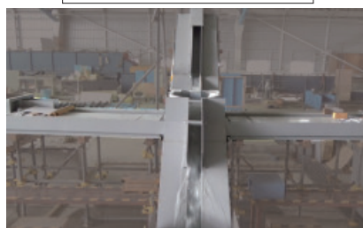
「マスマス整流ます」設置
