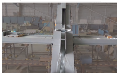
「マスマス整流ます」設置
