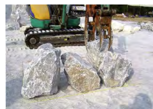
墨だし位置を参考に外周に石材を配置します。
