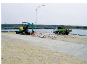
敷き砂で製作ヤードを整地します。
