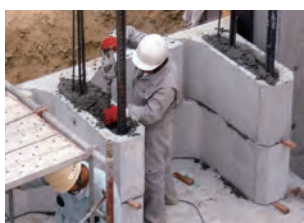
⑤ 縦貫コンクリート打設
