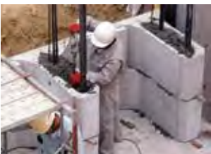
⑤ 縦貫コンクリート打設
