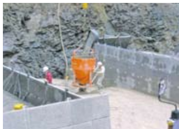
5.コンクリート打設状況
