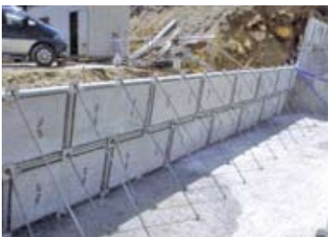
4.2段目設置完了状況
