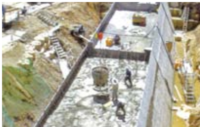
5.コンクリート打設状況
