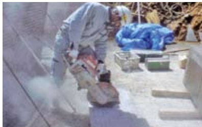
4.型枠パネル切断加工状況
