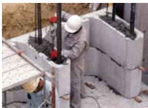
⑤ 縦貫コンクリート打設
