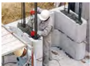
⑤ 縦貫コンクリート打設
