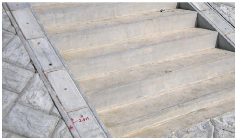
▲階段端部止工
