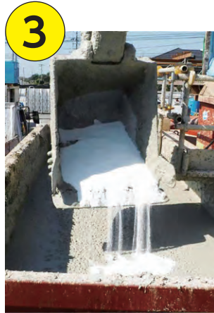
●バックホウで15分程度混合 (ドライミキシング等を使用すると、より均一に混合することができます)
