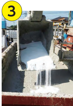
●バックホウで15分程度混合 (ドライブミキシング等を使用すると、より均一に混合することができます)
