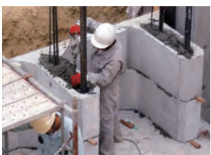
⑤ 縦貫コンクリート打設
