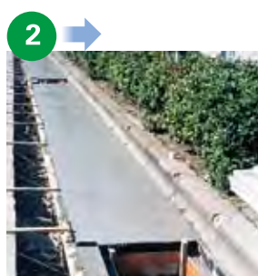
コンクリート打設
