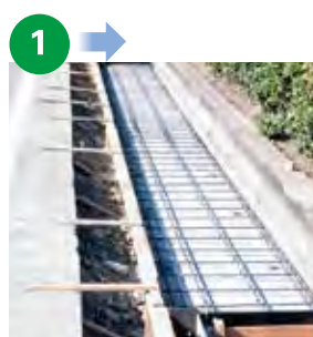
KCフォームの上に配筋した状態
