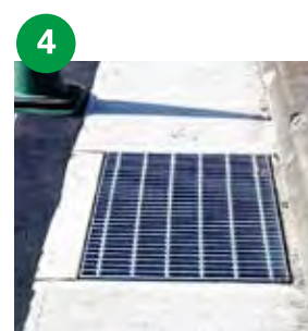
グレーチング設置
