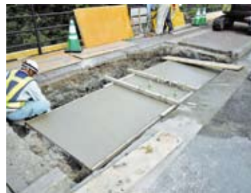
⑥所定高さまで打設。埋戻し・養生。
