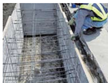
③型枠レベル調整
