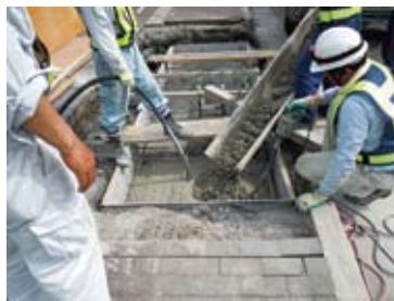
⑤生コン打設。周辺埋戻し。
