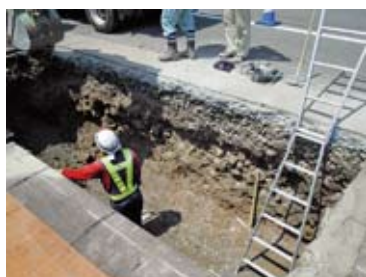
①掘削後敷砂
