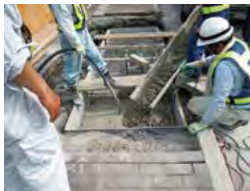
⑤生コン打設。周辺埋戻し。
