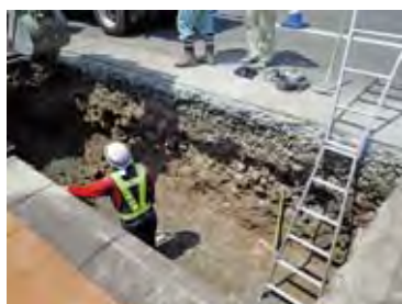
①掘削後敷砂
